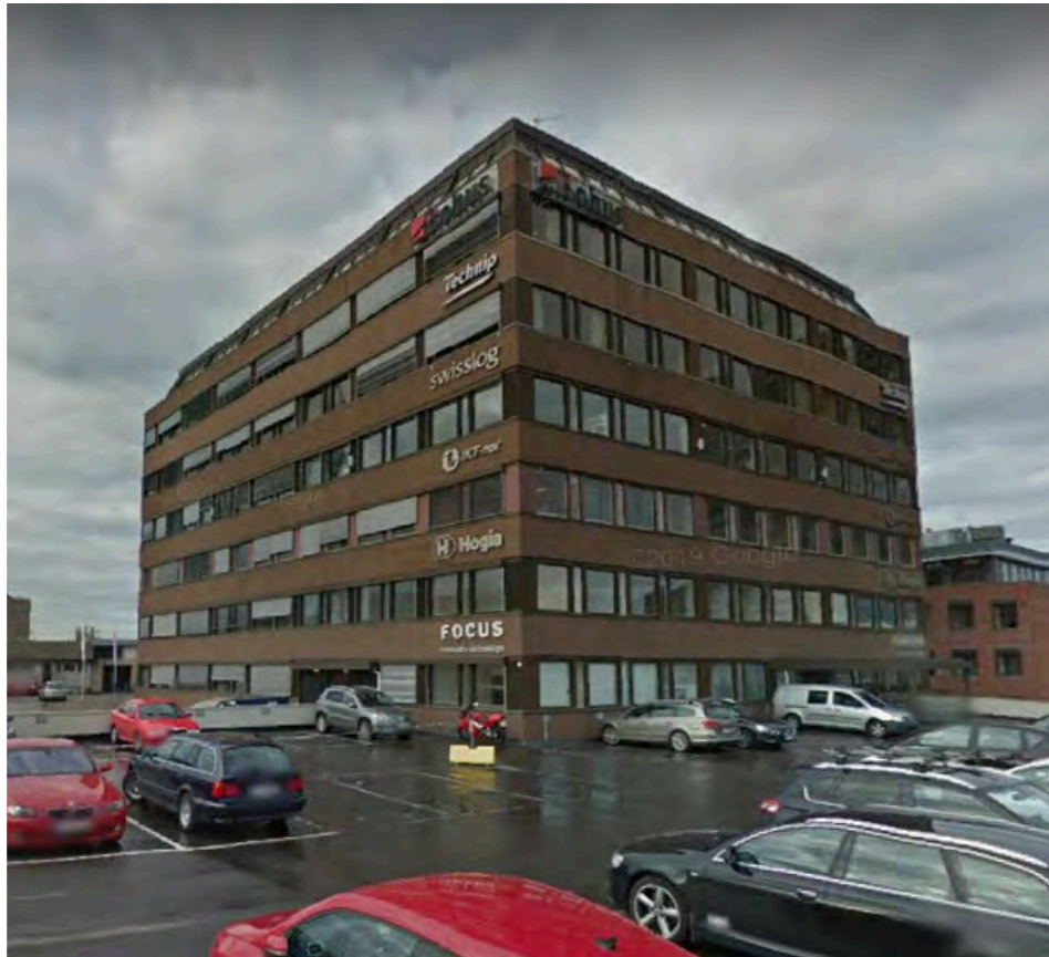
Økern: tilfeldig bygning optimal kontorbyggeri anno 1960
